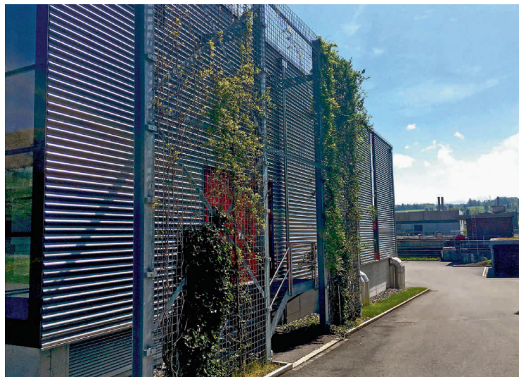
Fig. 2 Je nach Oberfläche können Pflanzen direkt an der Fassade oder, wie hier im Beispiel eines Areals des Abwasserverbands Morgental (AVM) in Steinach, an einer zusätzlich vor der Wand montierten Kletterhilfe hochklettern. Die Betreiber des Areals wissen um die Vorteile einer naturnahen Arealgestaltung und lassen ihr sorgfältig gepflegtes Areal nun durch die Stiftung Natur & Wirtschaft zertifizieren.
